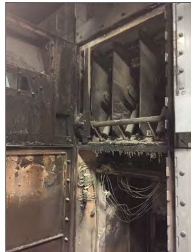
(d) Switchgear failure and fire
